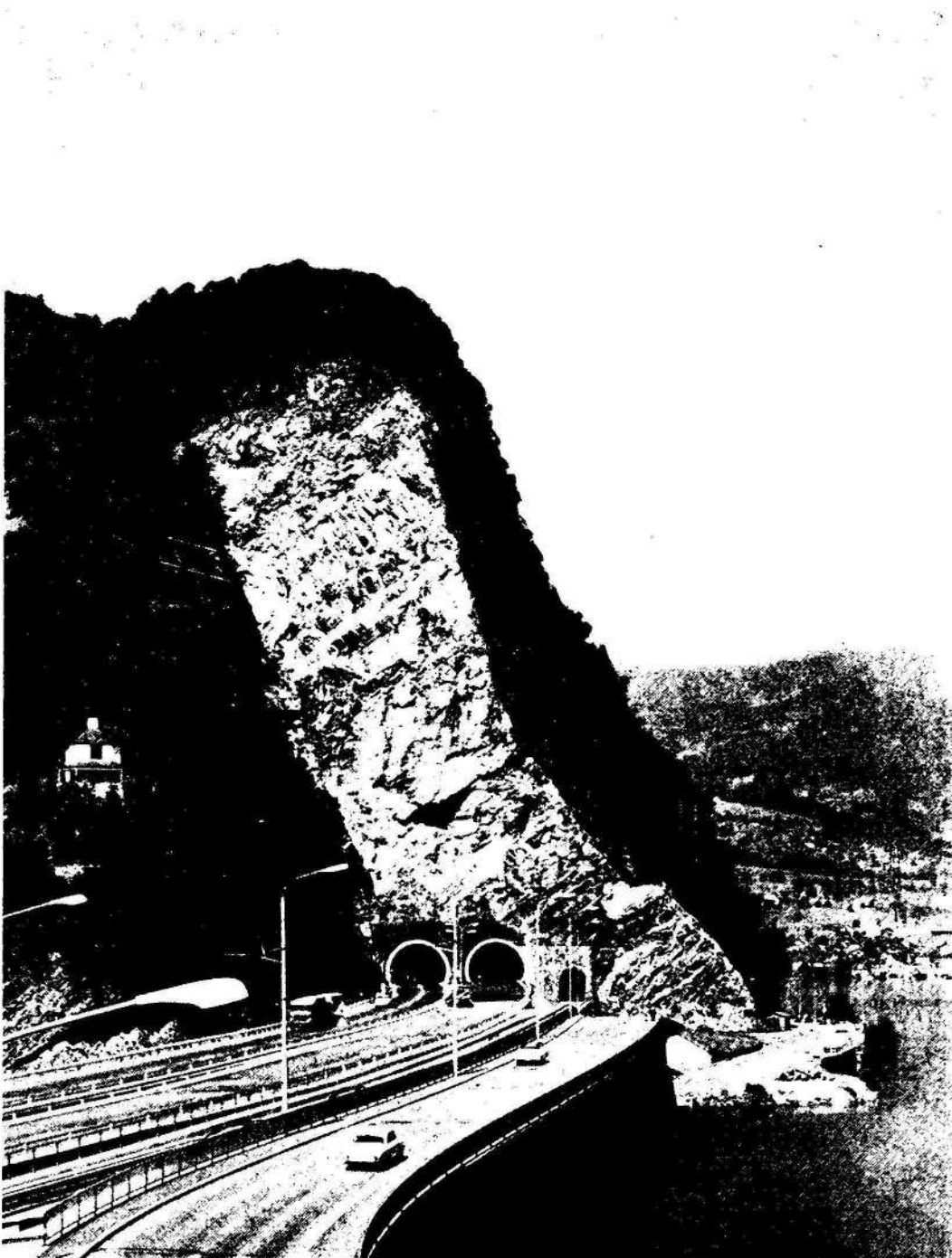
Blick auf die Achereggbrücke mit den Tunnelportalen für Strasse und Bahn
